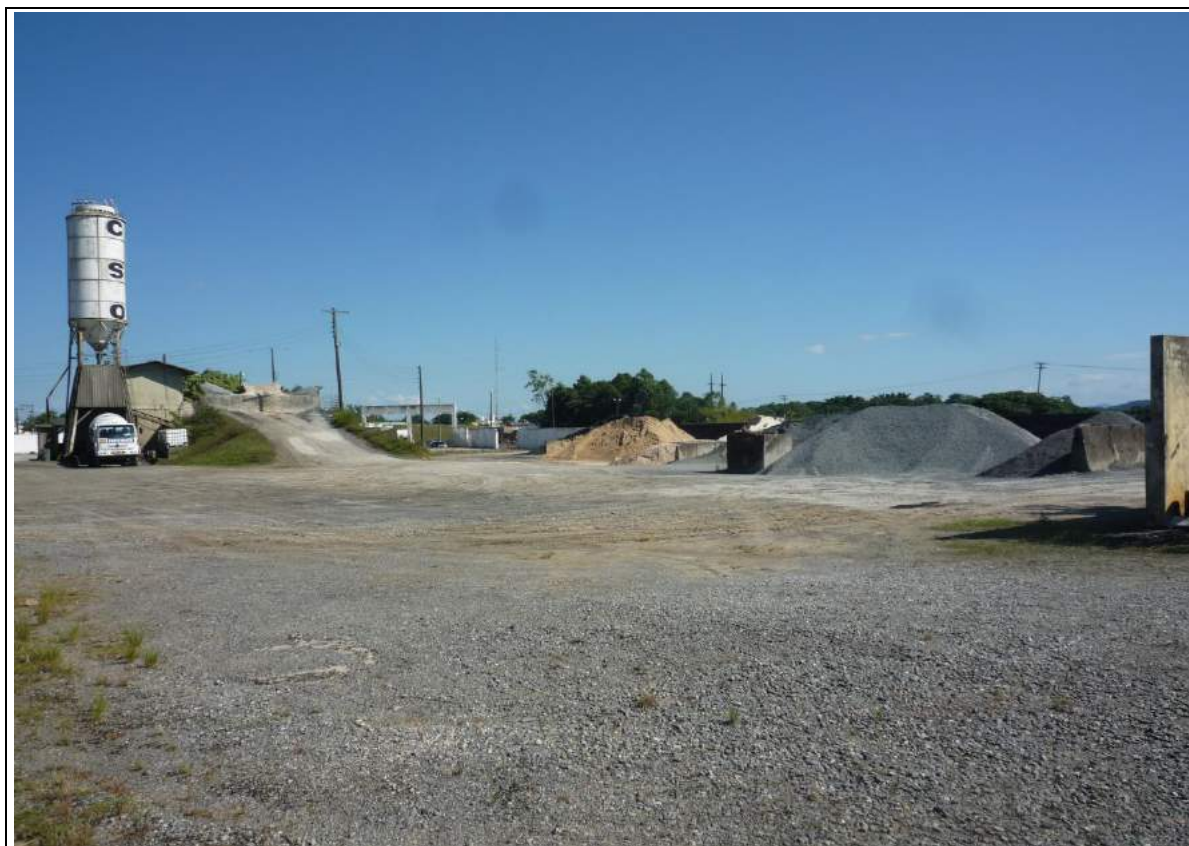
FOTO 06= VISTA GERAL INTERNA COM BAIAS DE ESTOCAGEM DAS MATERIAS PRIMAS PARA O CONCRETO USINADO
