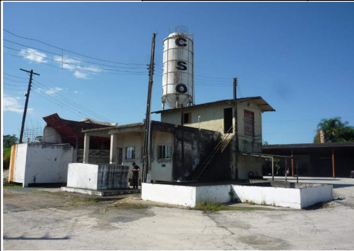
FOTO 13= VISTA DO SILO DE CIMENTO DA USINA DE MISTURA E CARREGAMENTO DOS CONCRETOS USINADOS
