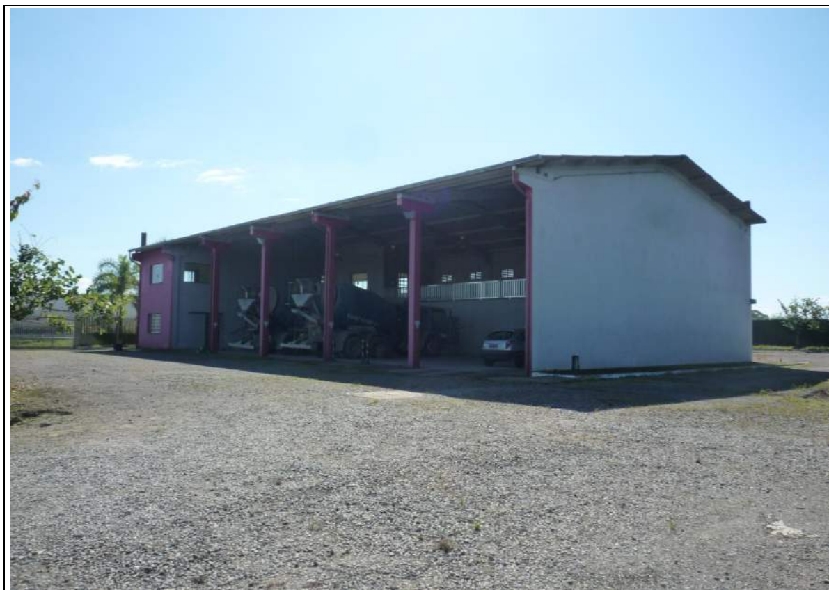
FOTO 08= NOVO PRÉDIO ADMINISTRATIVO E GARAGEM AMPLIADA
