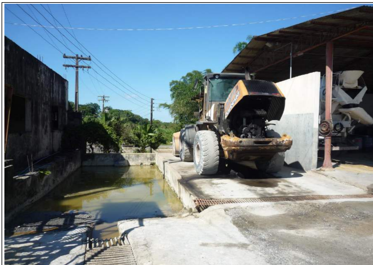
FOTO 12= LAVADOR E TANQUES DE DECANTAÇÕES
