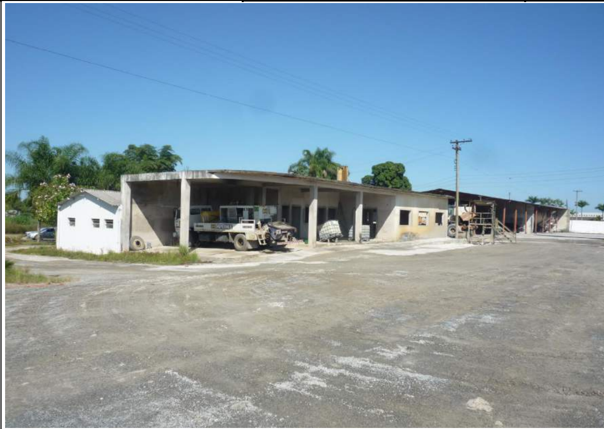
FOTO 07=GALPÕES DE APOIO PARA GARAGENS, OFICINAS E APOIOS
