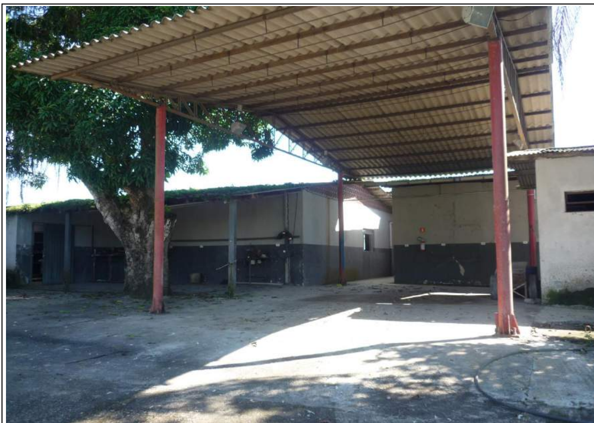
FOTO 10= OFICINA DE MANUTENÇÕES
