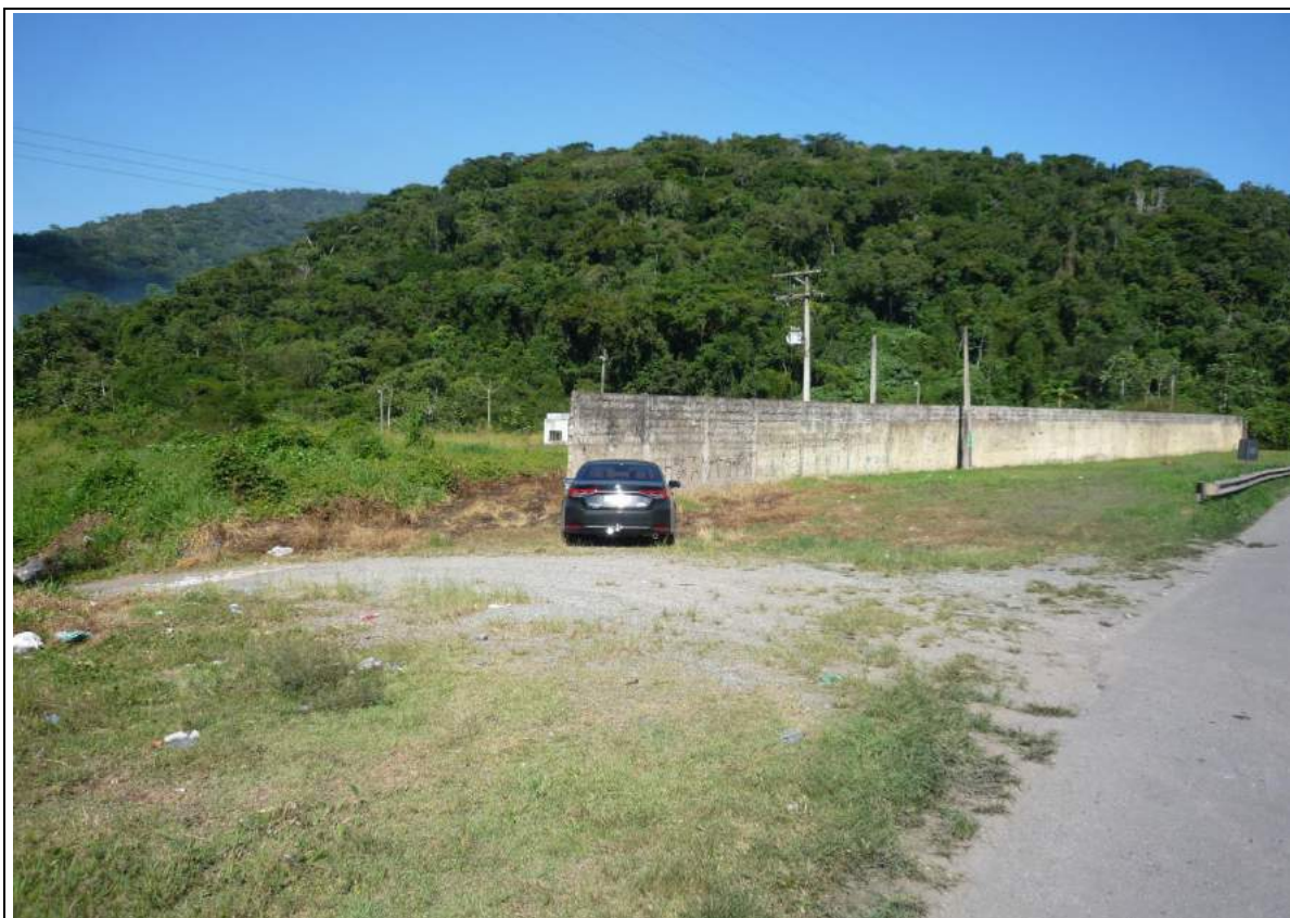
FOTO 04= VISTA DA ENTRA E ACESSO PELA RODOVIA BR-116
