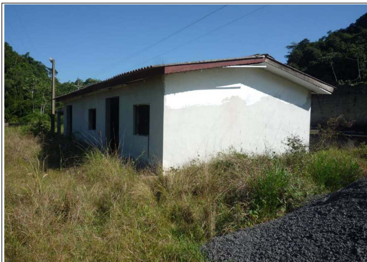
FOTO 06= VISTA DA EDIFICAÇÃO EM ALVENARIA EXISTENTE
