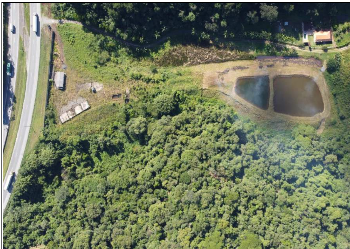
FOTO 02= IMAGEM VISTO DE CIMA TIRADOS COM DRONE
